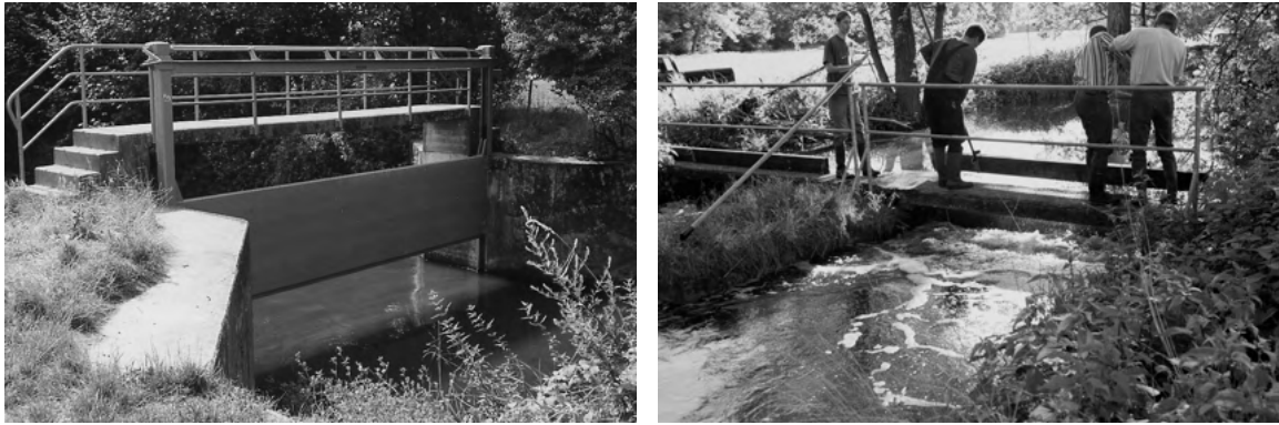
Abbildung 5: Zwei Hauptschleusen an der Queich. Links die moderne Schließe in Landau Queichheim und rechts eine Schließe in Ottersheim, die noch per Hand zugestellt wird.
