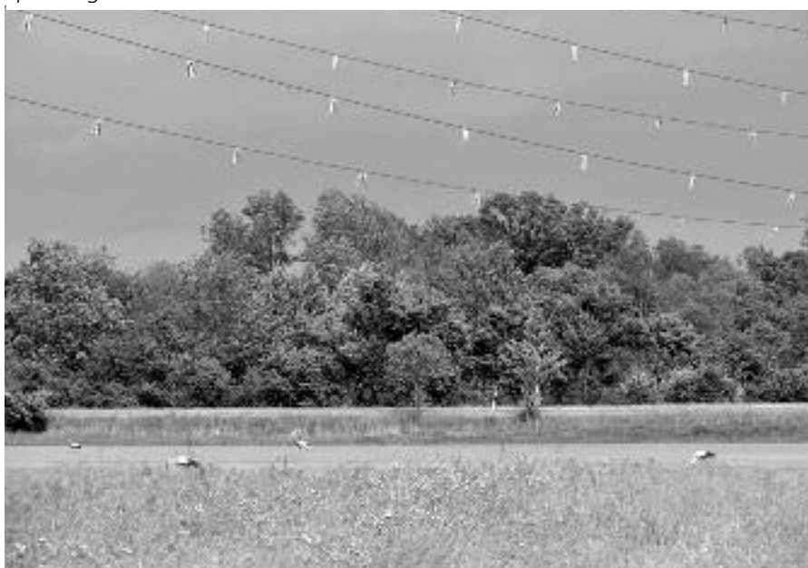
Abb. 2: Sichtmarkierung der Leitungsseile verhindern erfolgreich tödliche Kollisionen (Niederwiesen bei Offenbach/Queich).
